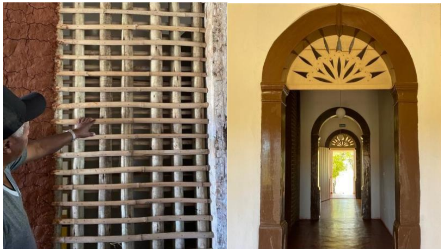
Figura 16 – Típica construção de Taipa Figura 17 – Interior da Sede
